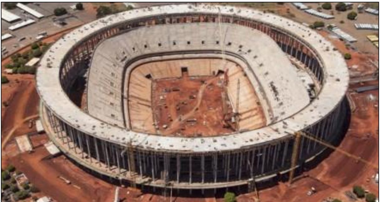
Figura 05 – Foto da obra do Estádio Nacional
